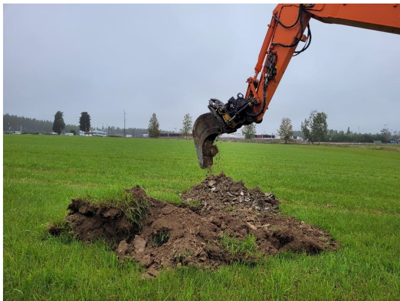
Figur 4. Provgrop 21T01PG. Foto: Tyréns 2021-09-10.
