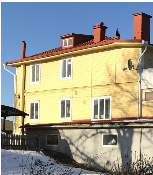
Foto fasad mot söder 2023
