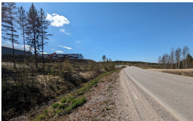
Bild 4. Från vägen sluttar det kraftigt ned i diken där dagvatten samlas upp och transporteras vidare mot Bomyran. Kvartersmarken har prickmark närmast som också har hög lutning. De avvattas också till diken.
