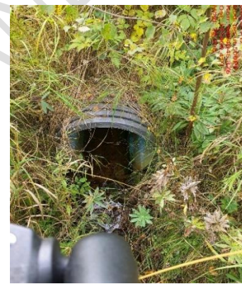
3. Utlopp på trumman under Fallsängesvägen.
