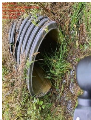
2. Utlopp till markavvattningsföretags dike.
